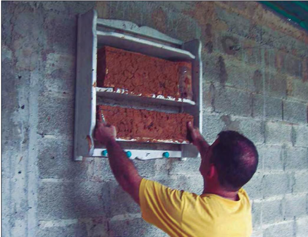
Figura 44. Sellado de las hendiduras y aislamiento adicional utilizando barro.
